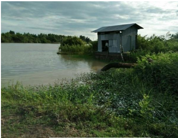
บริเวณจุดตั้งสถานีสูบน้ำ
